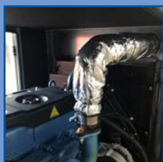
Țevi de eșapament cu izolație termică pentru performanță ridicată și siguranță
