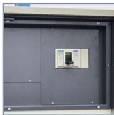
Comutator general montat pe panou pentru o conectare confortabilă și sigură
