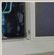
Uși de inspecție cu cadru dublu și garnitură etanșă
